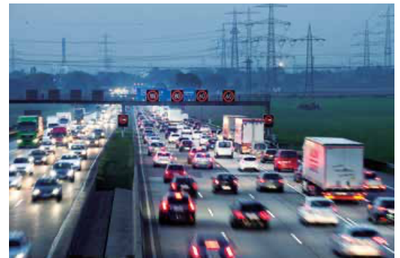
Das wachsende Verkehrsaufkommen auf Autobahnen sorgt für stockenden Verkehr, Staus, Lärm und Abgase. Ein intelligentes Verkehrsmanagement mithilfe von SBA schafft Abhilfe
